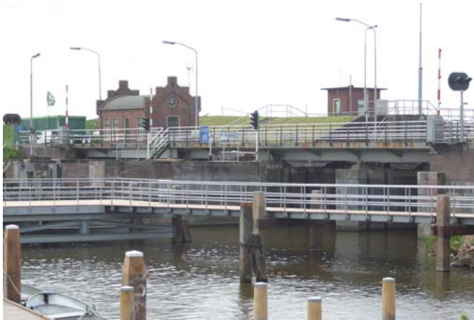
De Provinciale Sluis in Zoutkamp tussen het Reitdiep en het Lauwersmeer.
