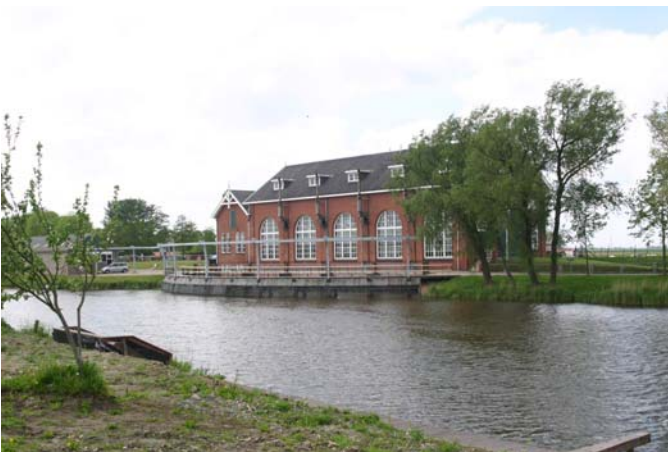
Gemaal De Waterwolf is een van de grootste gemalen in Nederland. Het werd in 1921 gebouwd voor de ontwatering van het zuidelijke deel van Hunsingo, het Westerkwartier en het noordelijke deel van Drente. Vanuit het Kommerzijlsterrijt wordt het water uitgeslagen op het Reitdiep. Bij het gemaal ligt een schutsluis die in dezelfde tijd is
