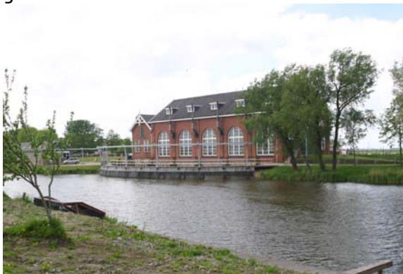
Gemaal De Waterwolf is een van de grootste gemalen in Nederland. Het werd in 1921 gebouwd voor de ontwatering van het zuidelijke deel van Hunsingo, het Westerkwartier en het noordelijke deel van Drente. Vanuit het Kommerzijlsterrijt wordt het water uitgeslagen op het Reitdiep. Bij het gemaal ligt een schutsluis die in dezelfde tijd is gebouwd.
