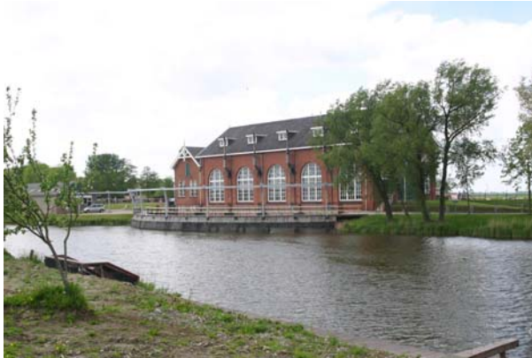
Gemaal de Waterwolf, in 1921 gebouwd voor de afwatering van het Westerkwartier, Hunsingo en het noordelijke deel van Drenthe
