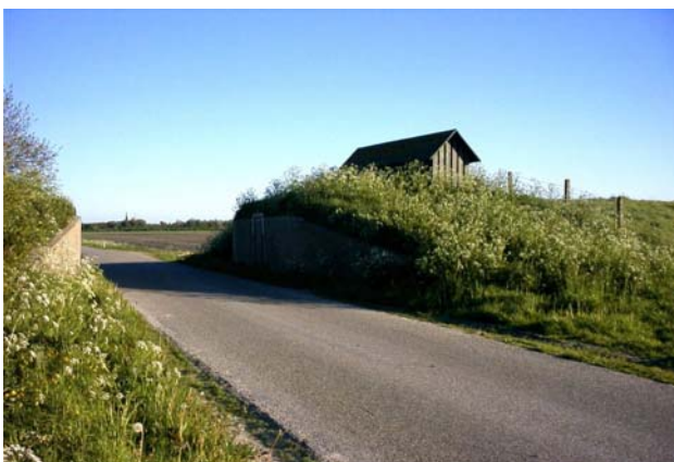
Dijkcoupure met schotbalkenloods in de Noordpolder. Foto: Dré van Marrewijk
