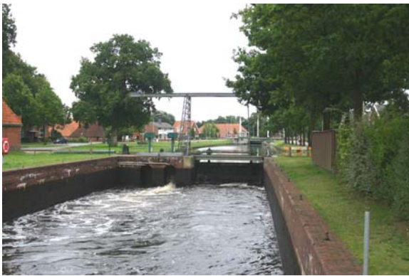
Sluis nummer 6 in het Ter Apelkanaal. Het patroon van wijken, monden en kanalen bepaalt het landschap van de veenkoloniën. Naarmate de hoger gelegen veengebieden vergraven werden moesten er in de kanalen schutsluizen worden aangelegd om de hoogteverschillen te overbruggen.
