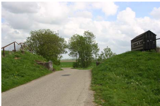
Coupure in de Oude Provinciale Dijk bij boerderij Westerhorn, ten noorden van Ulrum. Na de aanleg van de Ommelanderzeedijk werd de Oude Provinciale Dijk een slaperdijk. In geval van nood kon de coupure worden gedicht met balken die in de balkenloods rechts op de foto werden opgeslagen.
