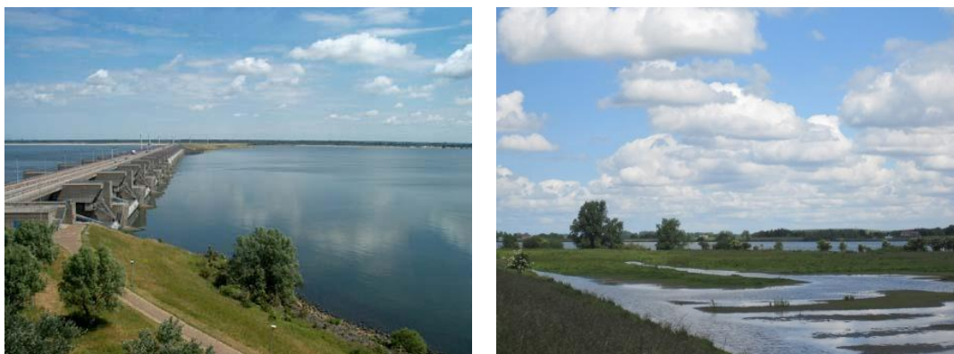
Foto 4.1 Links de Haringvlietsluizen en rechts aanliggend overstromingsgebied.
