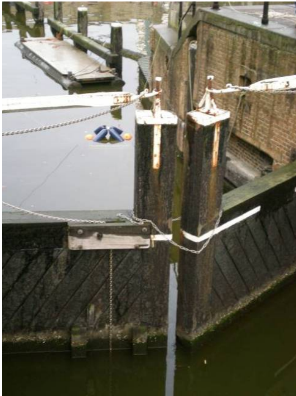
Foto 3.2. De sluisdeuren van het historisch sluisje op een kier (links), veroorzaakt door uit het sluisje gepompt water (rechts: de pomp).
