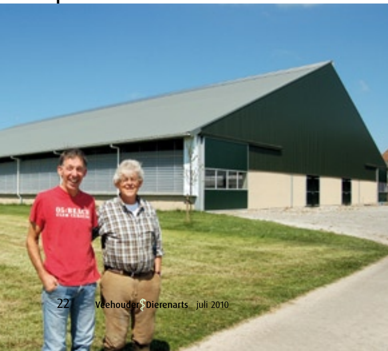
Foto 5. De opblaasbare gordijnen zorgen voor veel lichtdoorlaat en klapperen niet in de wind. Veehouder Auke Veldman en adviseur Ed van Eenige voor de stal.
