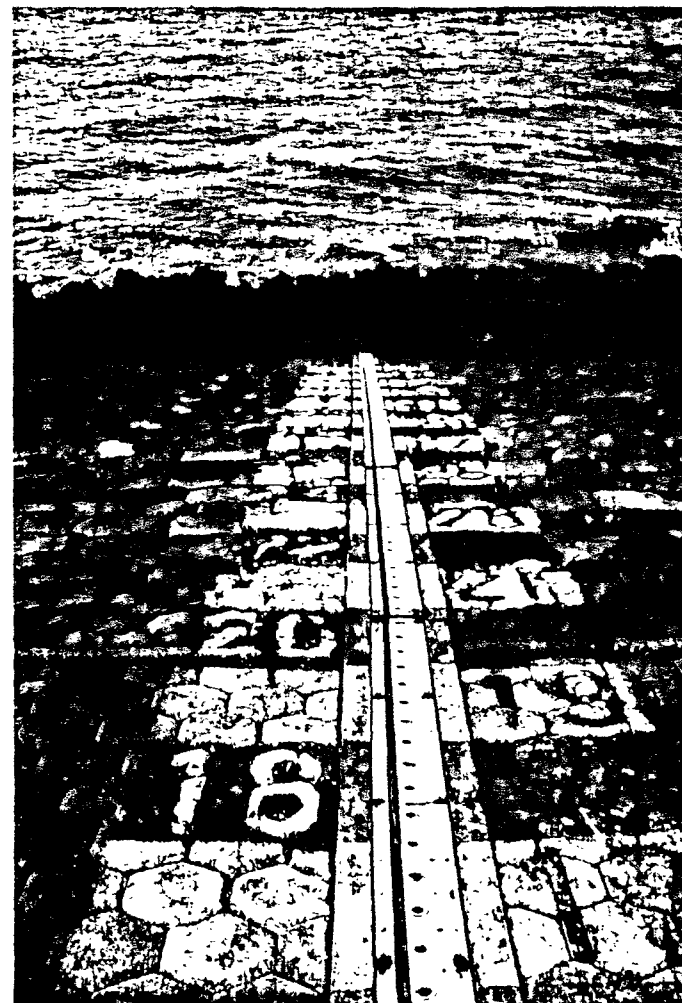
Dijktalud met electr. en visuele baak. Onderaan is tevens de plasberm zichtbaar.
