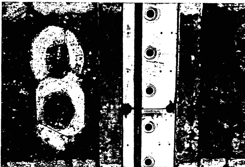
Detail electronische oploopbaak Zichtbaar zijn enkele electroden en de aardstrip.
