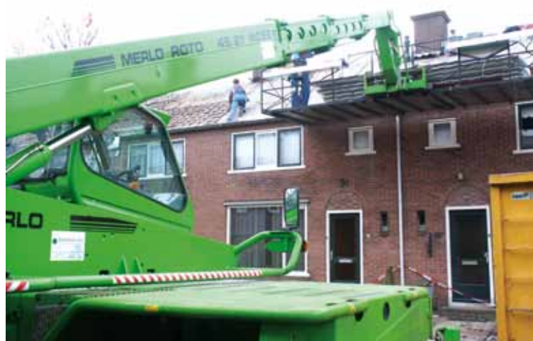
Verreikers met hoogwerkerplatforms dienen te voldoen aan de eisen zoals gesteld in de EN 280-norm.
