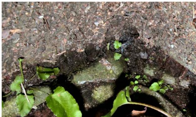
fig. 4: zonering in de bodemafzetting: op het beton van de bovenkap is een grof strooisel afgezet, op de bakstenen stelrand daaronder bevindt zich een mat van donker humeus materiaal, algen en mossen.
