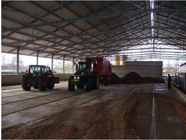
Aanleg stal in december 2010 met beluchtungsbuizen Een halve meter houtsnippers wordt in de stal gebracht
