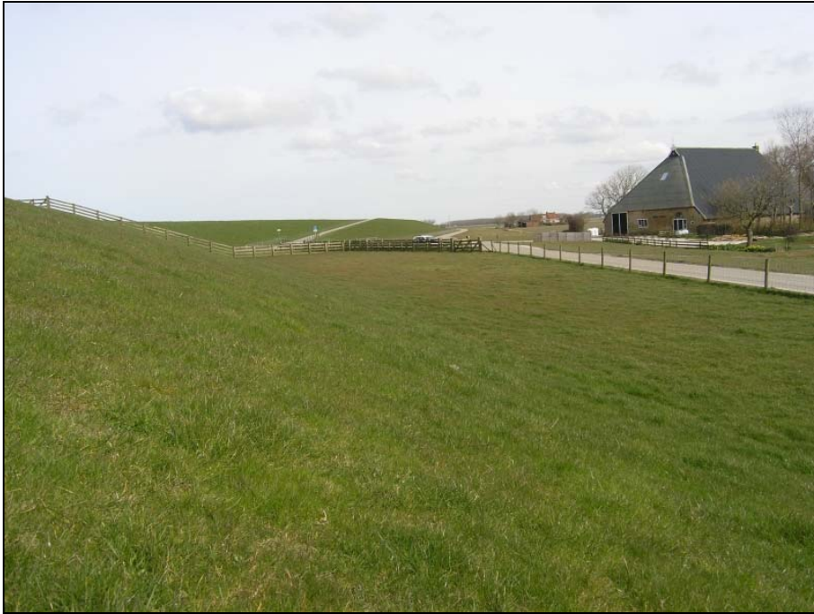
Holwerd: proefvak 104 (dijkvak 63; dijkpaal 35.5-35.6)
