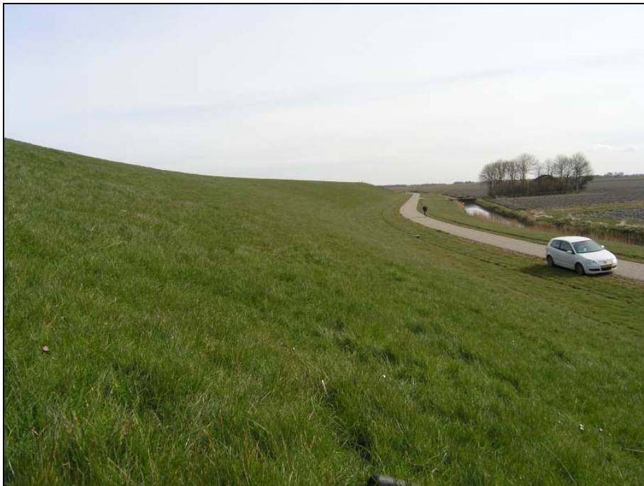
Holwerd: proefvak 102 (dijkvak 69; dijkpaal 41.4-41.5)
