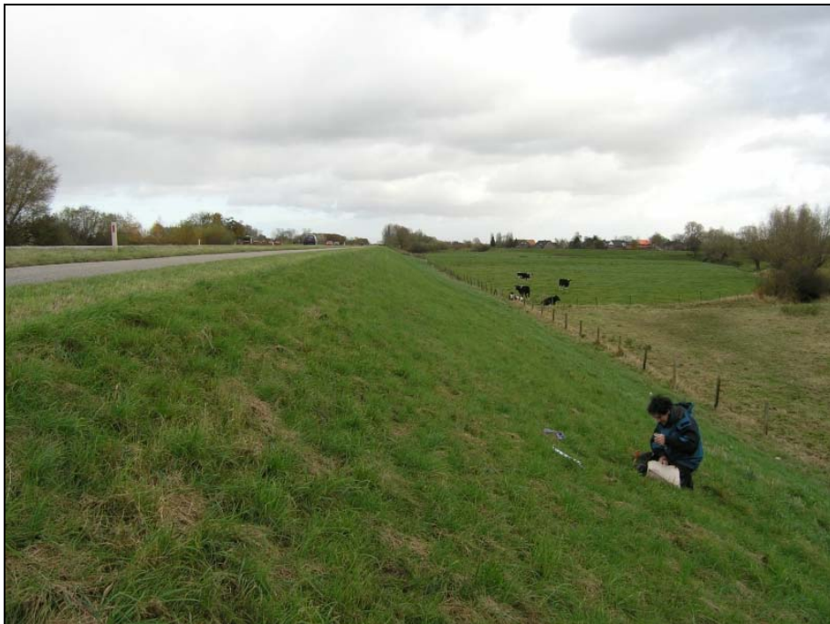
Rhederlaag: proefvak 322 (dijkpaal 314-315)
