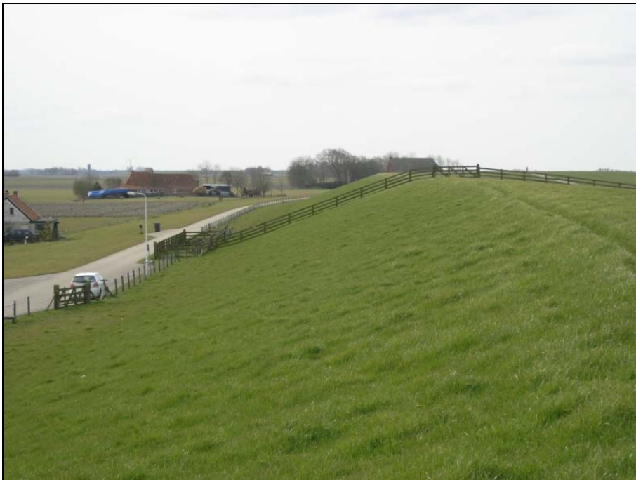
Holwerd: proefvak 105 (dijkvak 61; dijkpaal 34.4-34.5)
