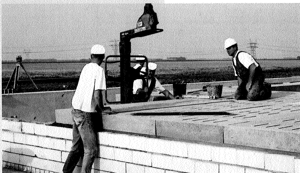
Het plaatsen van ventilatieroosters
