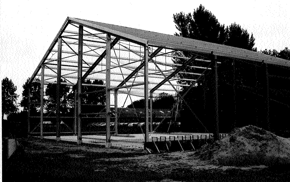
Een bewaarloods in aanbouw
