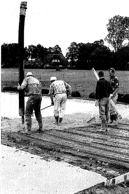
Uitvoering van de betonoverlaging in 1998
