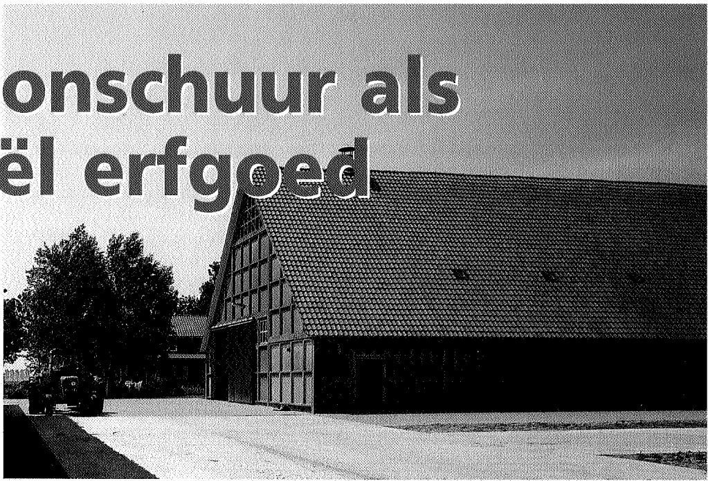
Bijna 1000 bedrijven in de Noordoostpolder kregen in de periode 1949-1962 een in montagebouw uitgevoerde Schokbeton-schuur
