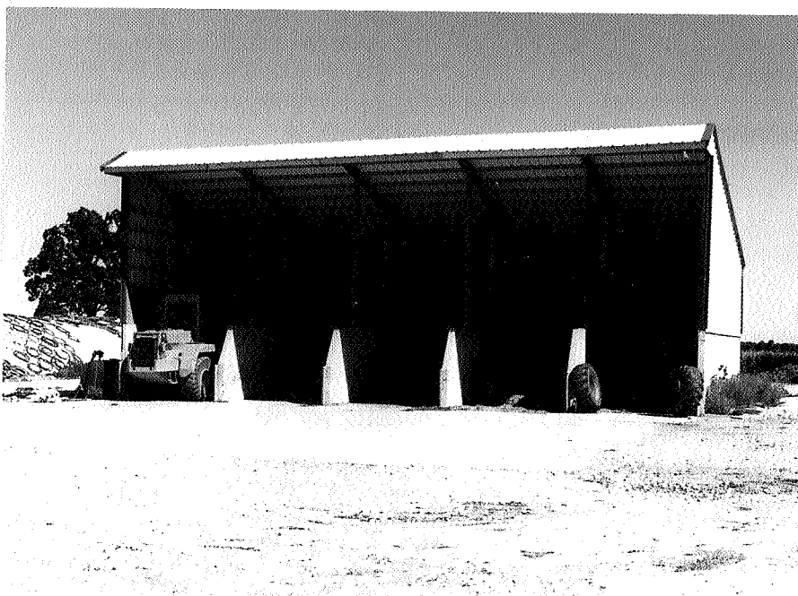
Overdekte opslagloods voor verschillende soorten krachtvoer met gedeeltelijk betonwanden
