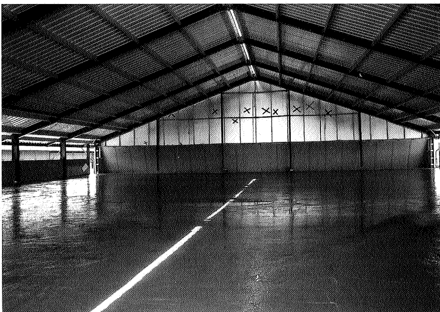
Plassen op een vloer in een pluimveestal die zojuist met een drijvende rei is afgewerkt
