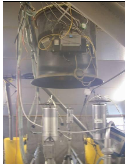
Luchtuitlaat met meetapparatuur
