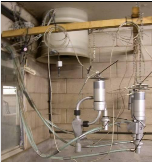
Luchtuitlaat met meetapparatuur
