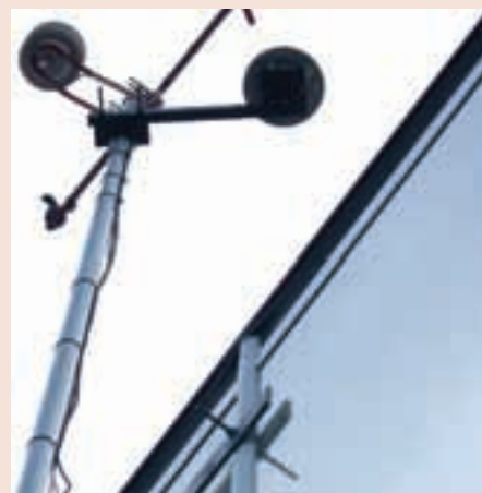
Bij een naderende regenbui krijgt de klimaatcomputer via de Meteoradar een seintje en worden de ramen gesloten. Dat voorkomt het natslaan van het gewas.
