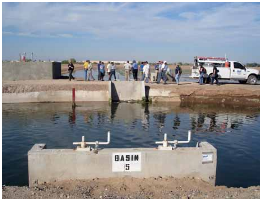
Een infiltratiepand bij Phoenix.
