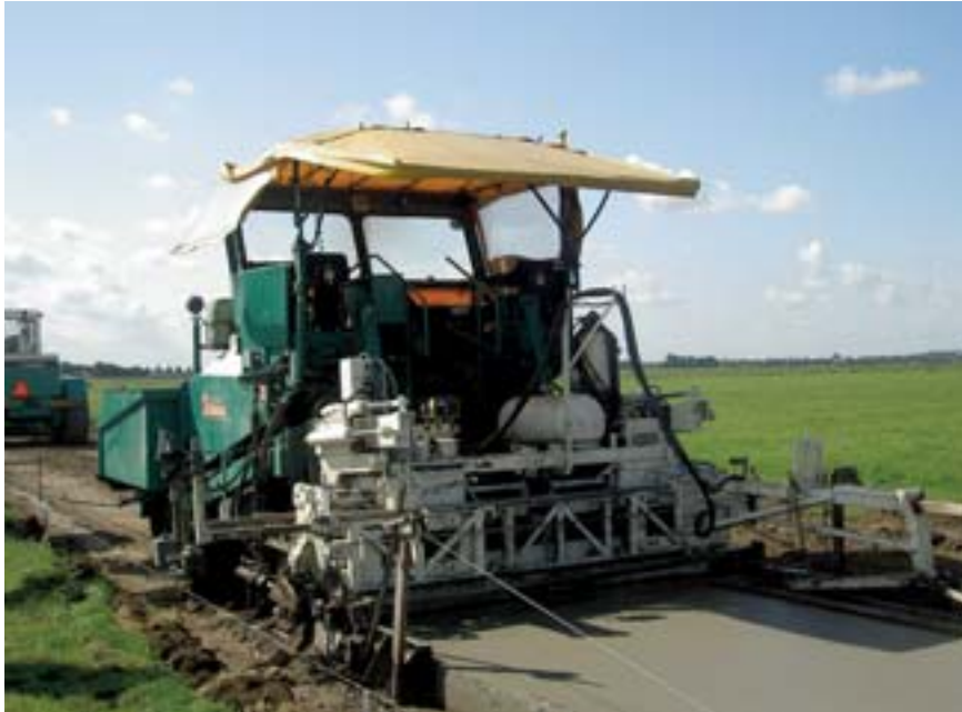
Een slipformpaver maakt in één arbeidsgang de verharding
