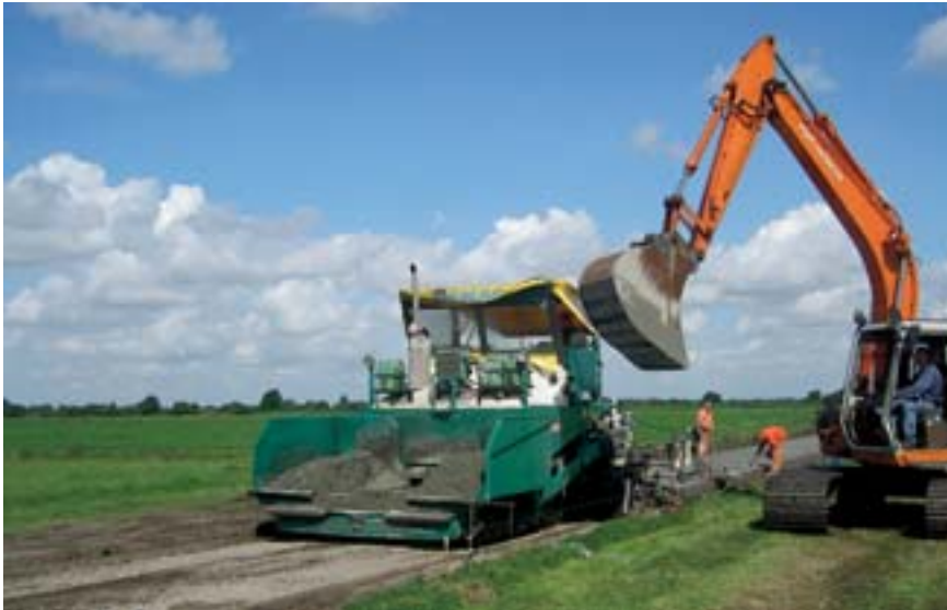
Controle van het beton
