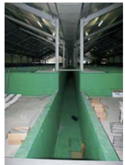
Tussen de bassins loopt een kanaal waarin de tilapia die rijp is voor de oogst wordt afgevoerd
