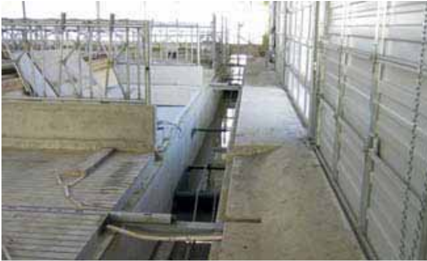
De mestschuif lost de mest in een verzamelgoot waar een schuif aan een ketting de mest naar een bezinkput trekt
