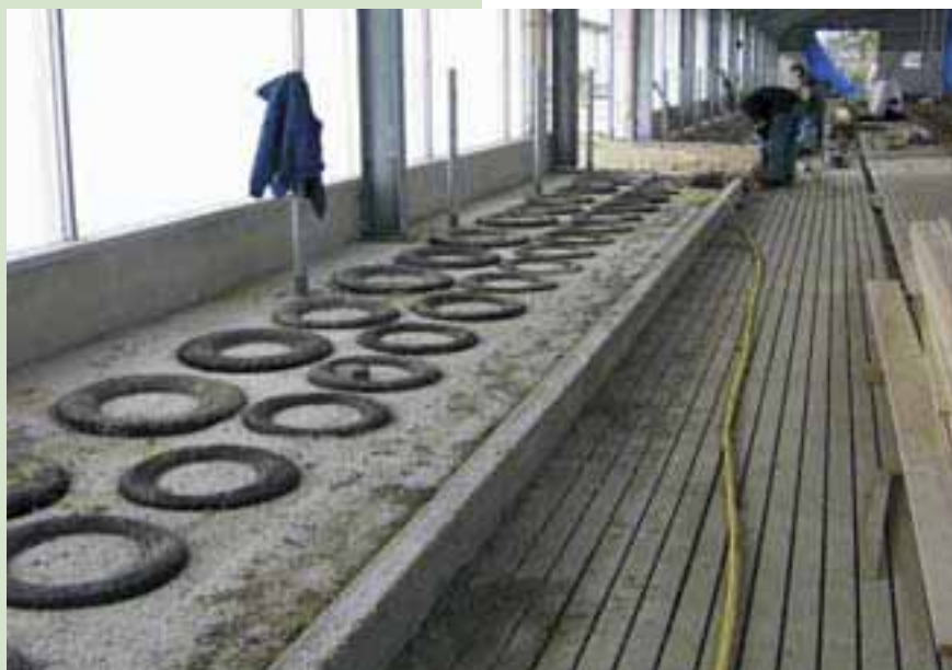
In de boxen zijn halve autobanden gelegd om uitkluwen van zand te voorkomen. Voor de boxen ligt de loopvloer met sleuven
