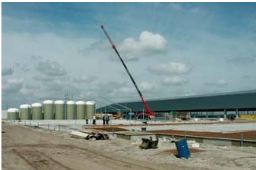
De voersilo's (links) en de stal in aanbouw
