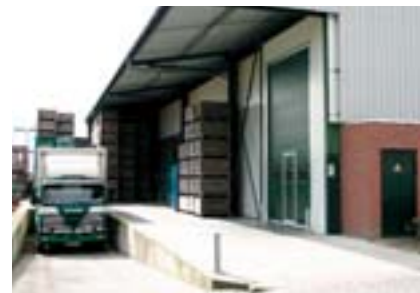
Laadkuil aangebracht bij de corridor
