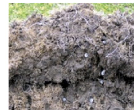
Schade aan de grasmat door engertingen.
