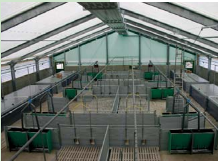
De Comfortclass in Raalte in aanbouw met lichtdoorlatende folie die aangebracht is op een staalconstructie
