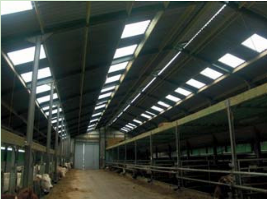
48 Vleeskoeien (links) staan aan een stand met keerbeugels op de grup en rechts het liggedeelte
