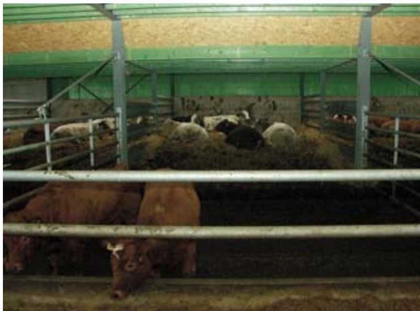
Het liggedeelte van de hellingstal heeft een helling van 7 %
