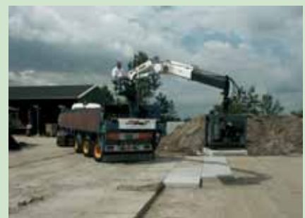
Het plaatsen van vloerelementen
