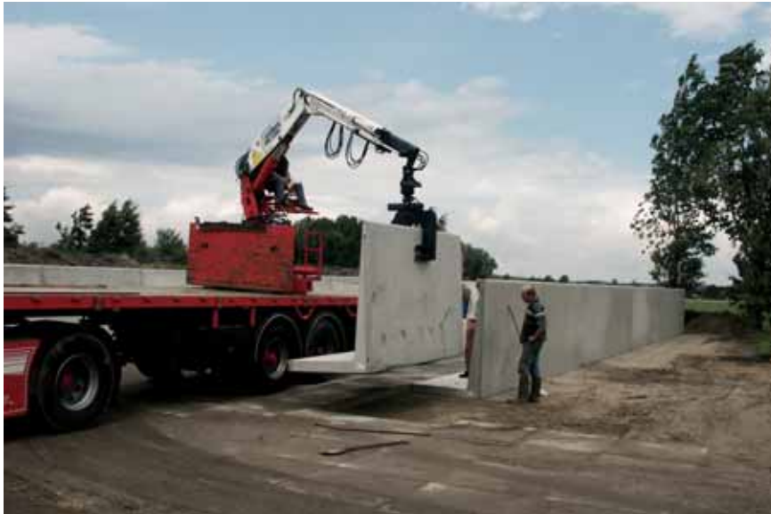
Het laatste wandelement wordt geplaatst
