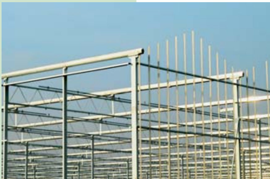
KnowHouse ontwikkelt een concept dat het gebruik van fossiele energie en de CO 2 -uitstoot fors omlaag brengt
