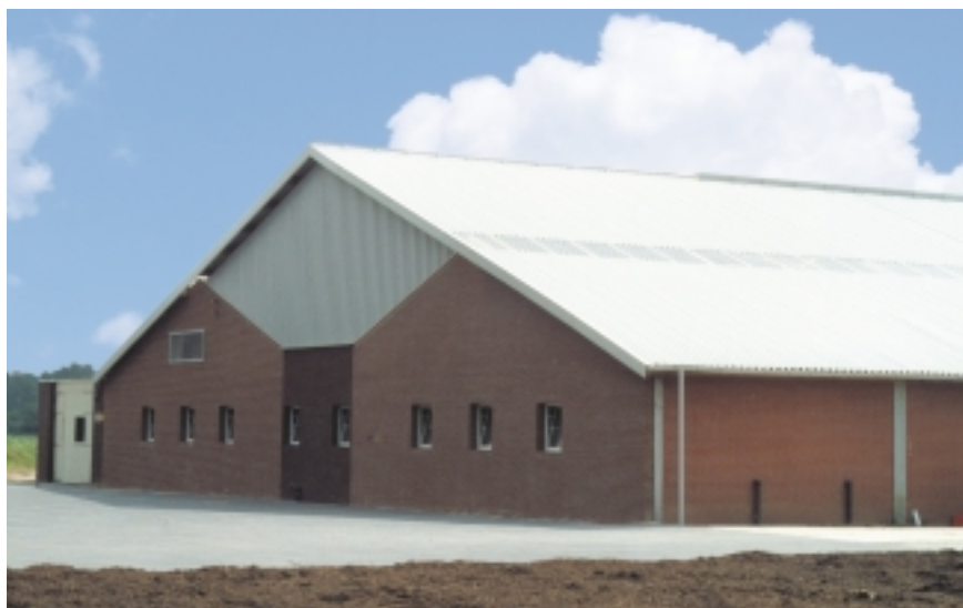
Op het dak van de geitenstal liggen polyester golfplaten
