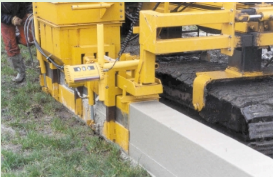
Machine voor aanleg strokenfundatie (glijbekisting)
