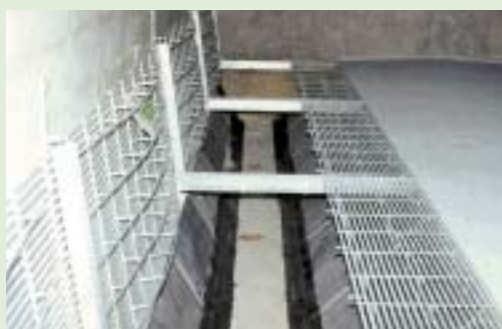
Het Groen Label systeem D 3.2.7.2 met dichte bolle vloer met metalen driekantroosters op het mestkanaal en schuine wanden in de mestput
