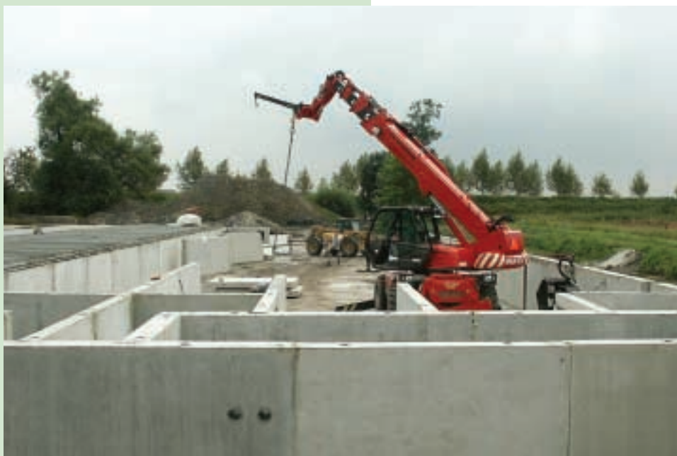
Een groot gedeelte van de onderbouw van de stal is geheel geconstrueerd met prefab betonnen elementen
