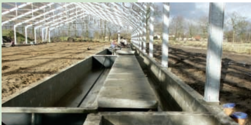
De mest die door de roosters valt komt terecht in een dieper gelegen dwarskanaal
