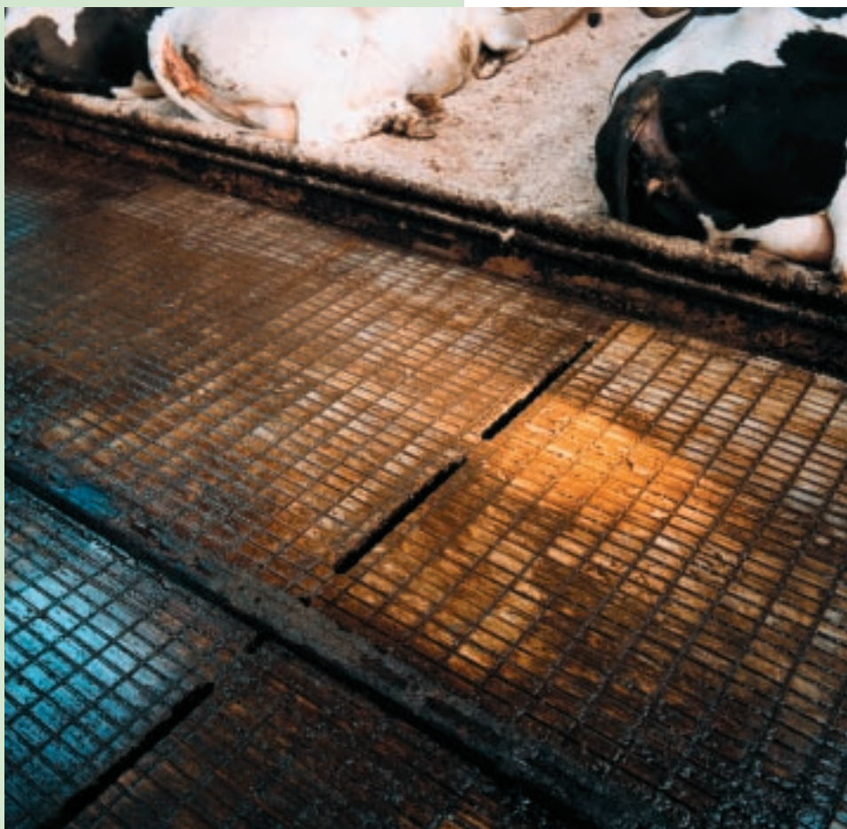
De HCI vloer bestaat uit dichte vloerelementen die voorzien zijn van een profilering voor de mestafvoer en grip
