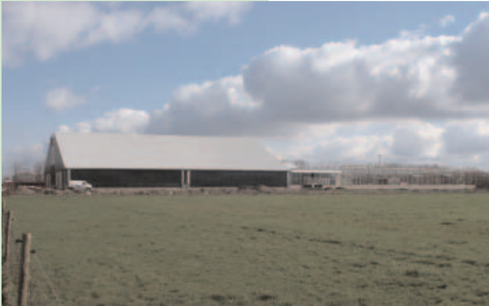
De nieuwe melkveestal van ASG, met rechts de serrestal
