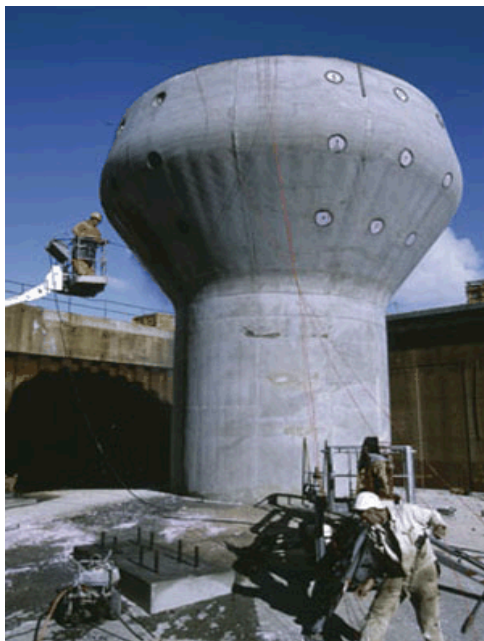
Figuur 3.3 Betonnen fundatie offshore turbines Middelen (bij Kopenhagen)
