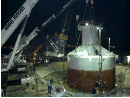
Figuur 3.5 Suction Bucket (zuiganker) voor een 3MW turbine in Denemarken. Bij toepassing van zuigankers zijn heipalen niet meer nodig
