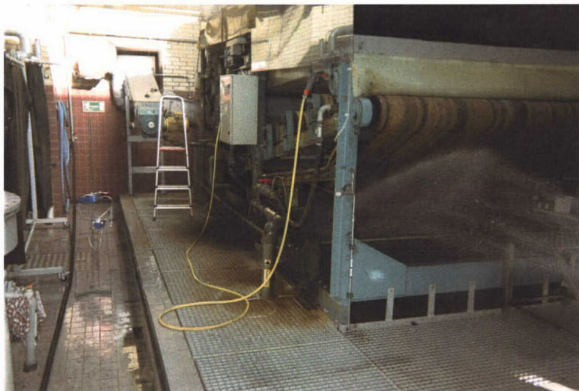
Foto 1: Ronde Venen: proefopstelling schoonmaakwerkzaamheden zeefband.
