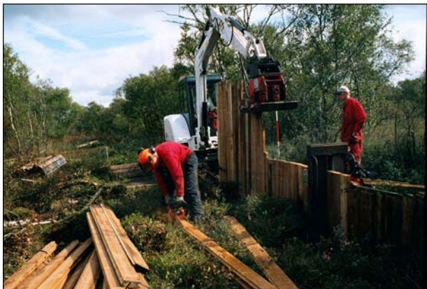
Fig.17: Voor het maken van de damwanden in Korenburgerveen is Plathout gebruikt (ontwikkeld door een LIFE-Milieuproject). (Foto G. Raeymaekers).
