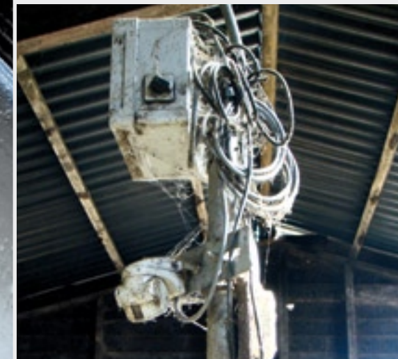
Een bewegingssensor detecteert wanneer de koe voor de spoelgoot komt en zet het systeem in werking.
