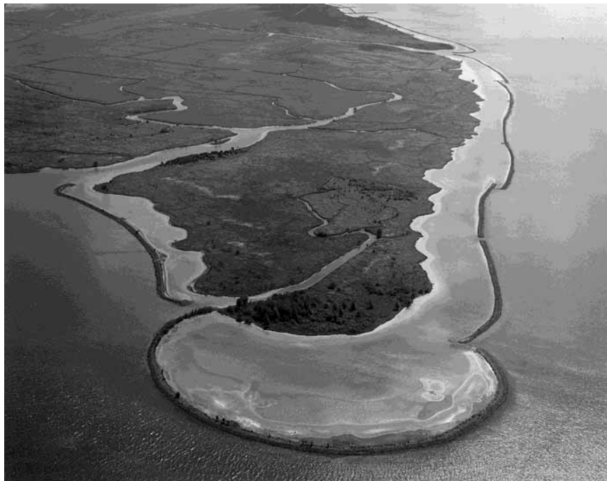
Luchtfoto van de oeververdedigingen bij de Korendijkse slikken in het Haringvliet.
