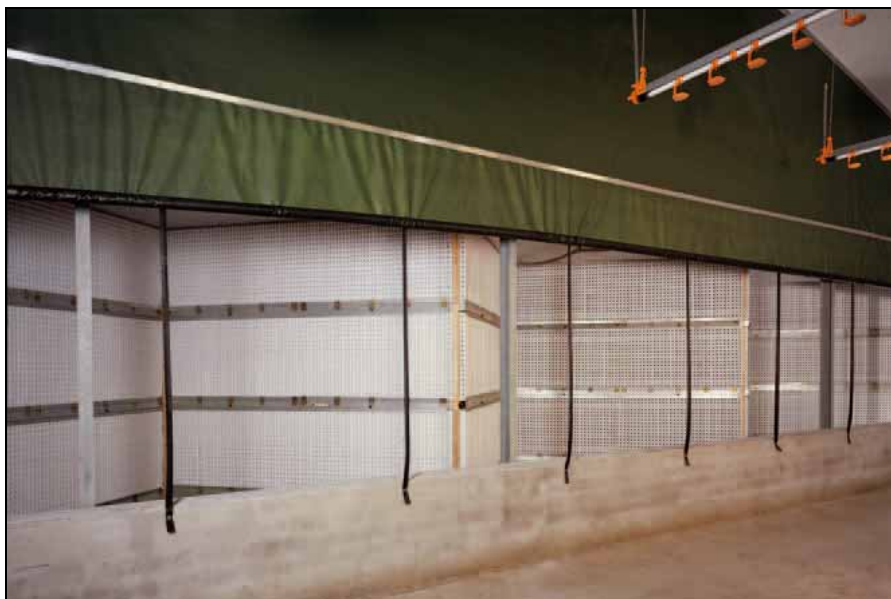
Figuur 3 Vooraanzicht van de filterwand, aanstroomzijde stallucht (Bron: brochure Big Dutchman)
