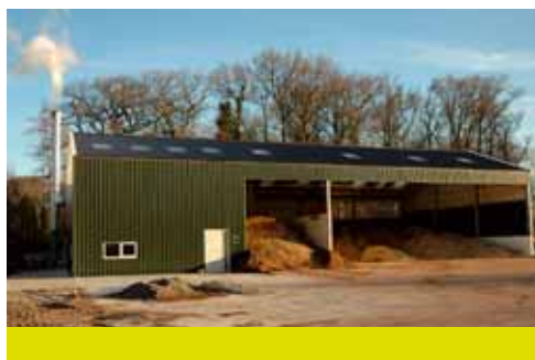
Hal voor biomassacentrale en opslag versnipperd snoeihout.
