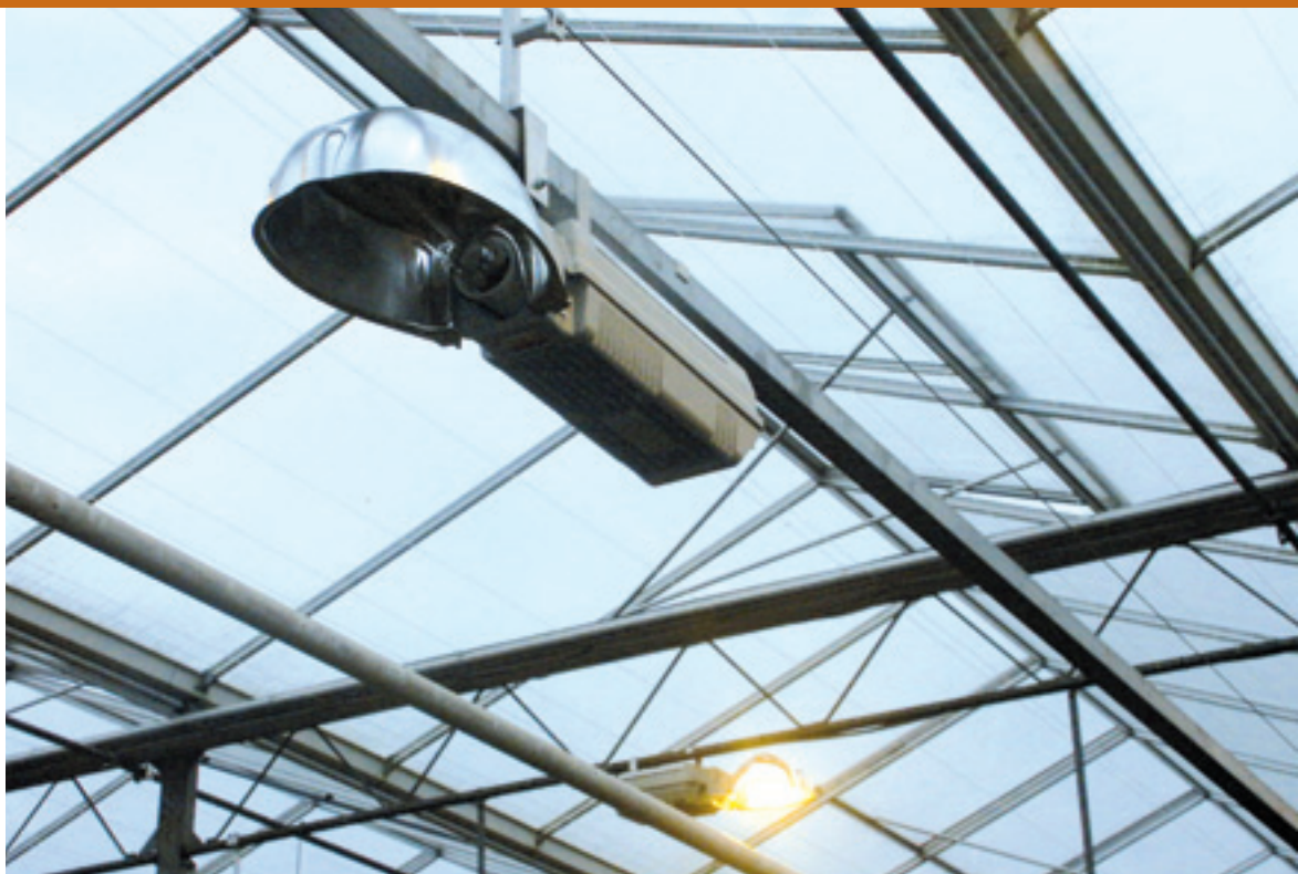
Van de 2000 benodigde armaturen zijn bij de Berckt-Roses 1000 lampen (op de foto de niet brandende lamp) bevestigd op een beweegbare constructie.
