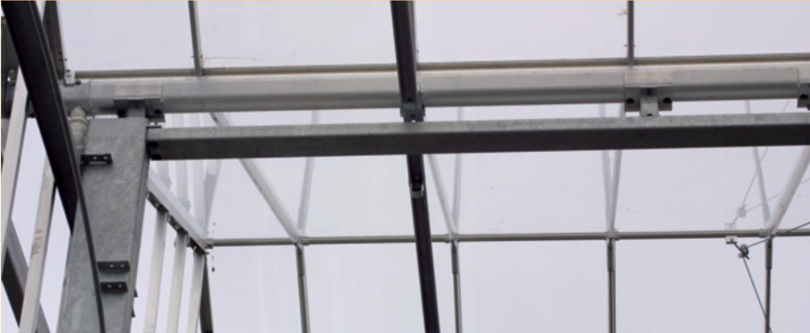
Een stalen balk tussen de laatste poot en de kopwandkolom vervangt de gebruikelijke momentverbinding.
