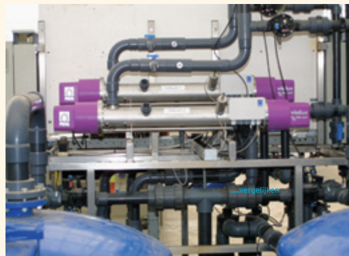
De Vialux HDUV-units kunnen elk 25 m 3 water per uur ontsmetten. Daarmee is Nuijten klaar voor toekomstige bedrijfsuitbreiding.
