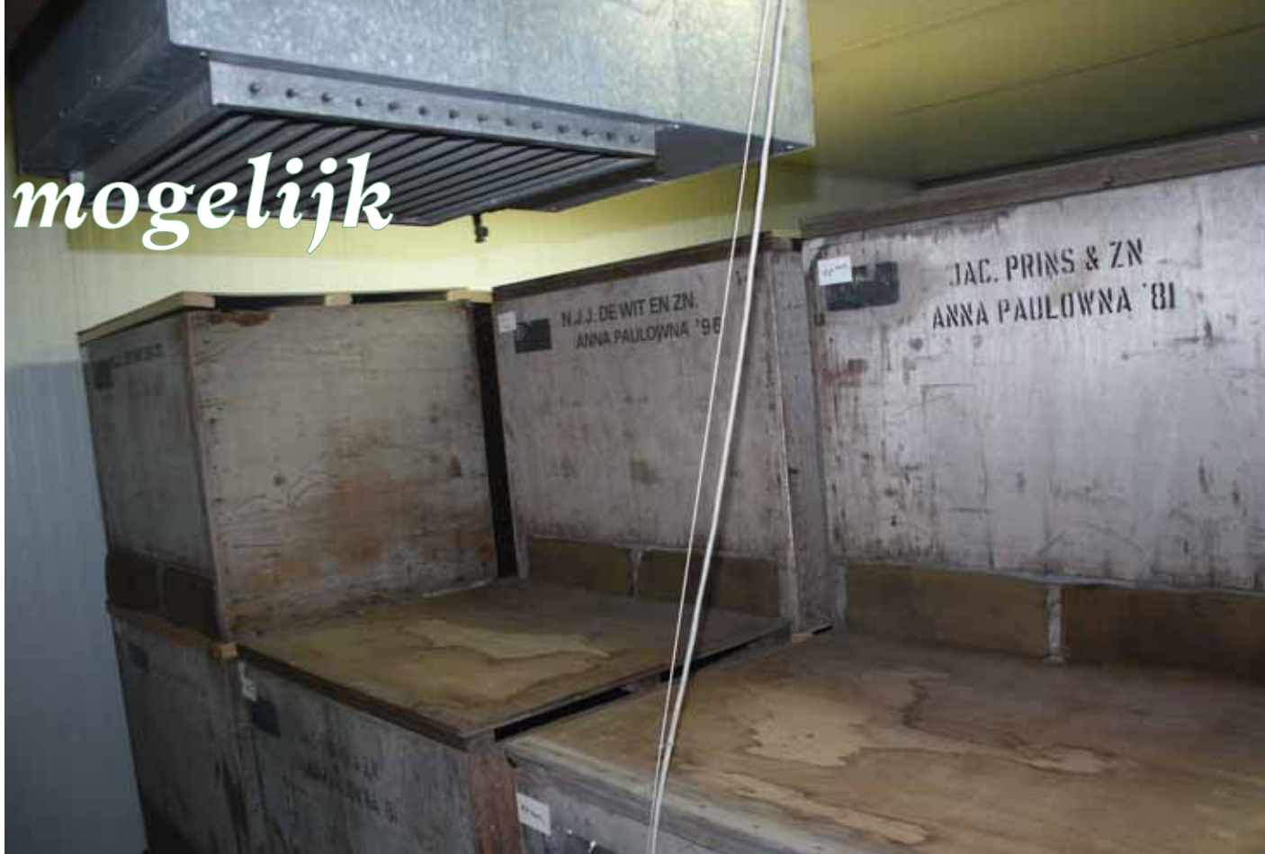
Platen op de bovenste kisten verbeteren de verdeling van de lucht
