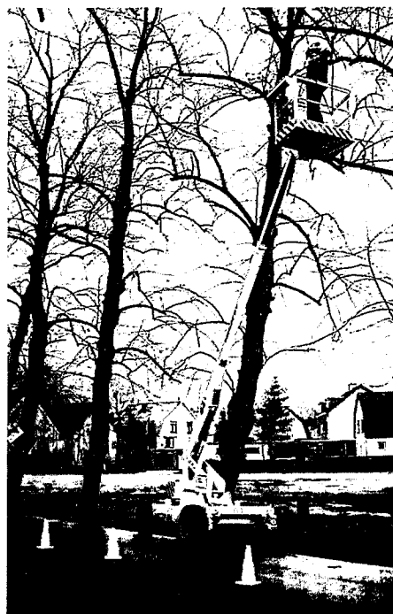
Figuur 4 – Voor deze berk is het reeds te laat: een gevaar voor weggebruikers.
