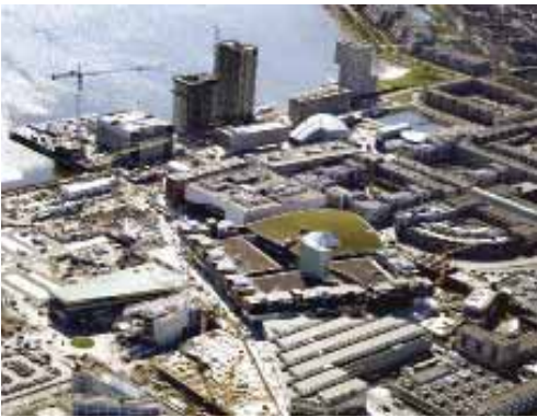
Nieuwe centrum van Almere. Foto: OMA (Office for Metropolitan Architecture)
