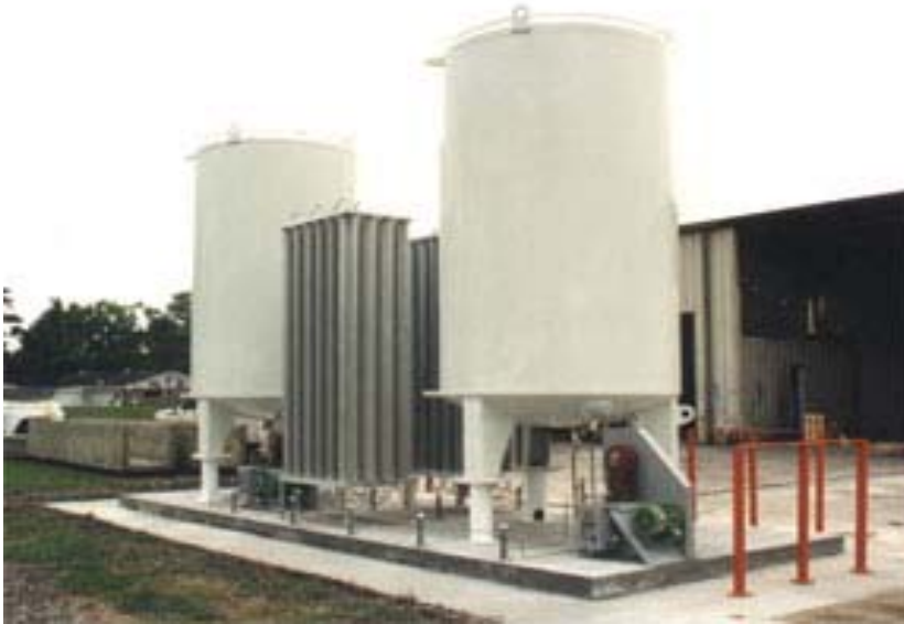
Figuur 7 CO 2 opslagtanks
